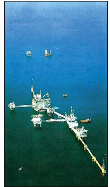
٥ استخراج النفط في بحر الشمال
