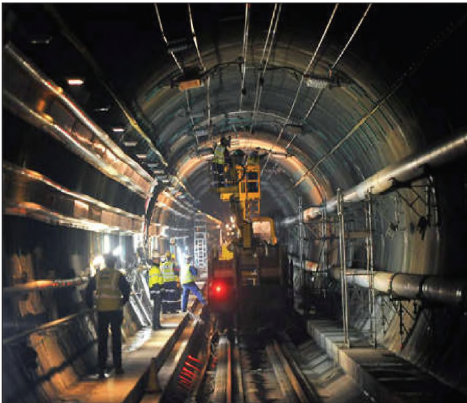
٤ النفق الذي يربط بريطانيا بفرنسا من تحت بحر المانش، أثناء حفره
