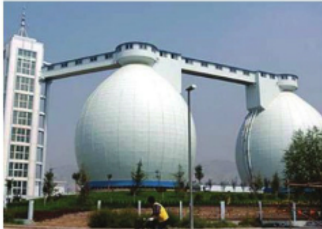
لصورة (٩) محطة لمعالجة مياه الصرف الصحي
