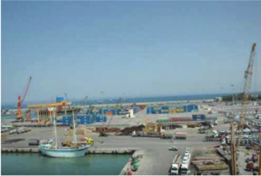
الصورة (١٢) ميناء اللاذقية
