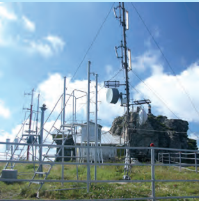
Platforma stației meteorologice Ceahlău-Toaca (1897 m)
