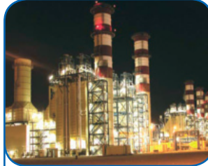
عدم صيانة محطات توليد الكهرباء
