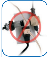
تحميل قوالب الكهرباء فوق طاقتها
