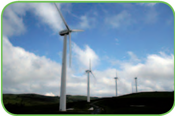
Campo energía eólica.
