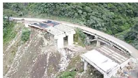
Construcción del puente ubicado en el sillar, Cochabamba.
