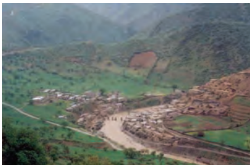
شکل ۳۸-۱- عدم رعایت حریم رودخانه و خطر سیل
