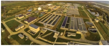
▲ Stația de epurare a apei – Cluj-Napoca
