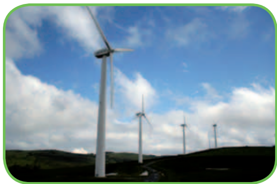
Campo energía eólica.
