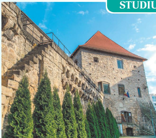
Cluj – Bastionul croitorilor
