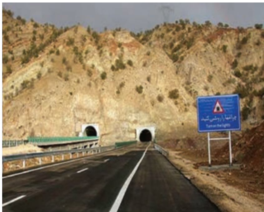
شکل ۱۲-۱۴- آزادراه خرم‌آباد - پل زال
