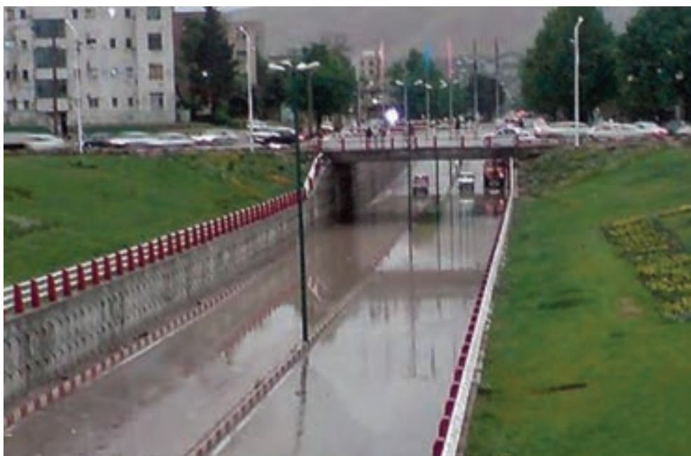
شکل ۱۰-۱۴- یکی از زیرگذرهای شهر خرم‌آباد
