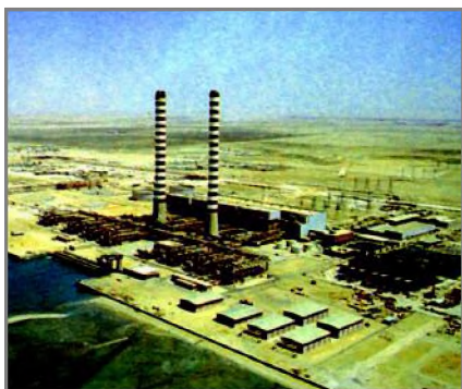
شكل ( ٤ ) محطة تحلية مياه.
