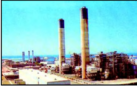
شكل (٤) محطة تحلية المياه
