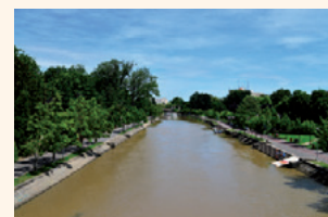
Bega, unul dintre râurile canalizate
