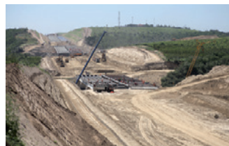
Tăierea versanților pentru construcția autostrăzii Cernavodă - Constanța
