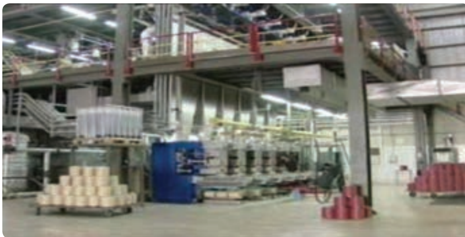
شکل ۱۵-۶ کارخانه کابل نوری یزد
