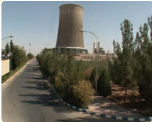
شکل ۱۰-۶- نیروگاه سیکل ترکیبی
