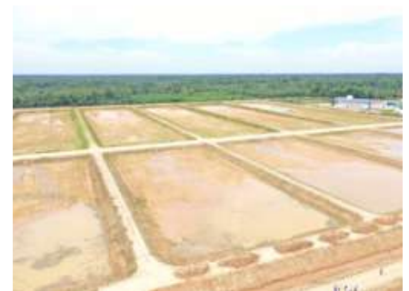
Construcción del complejo piscícola en Chimoré
