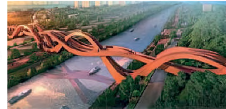
Puente Ondulado en China
