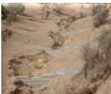
شکل ۱-۶۳- بند گابیونی (سنگ ها در تور سیمی)
