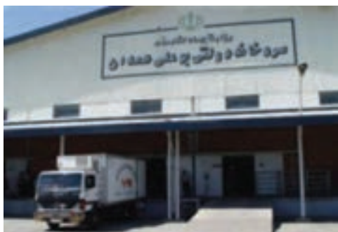
شکل ۲-۶- سردخانه بوعلی - همدان
