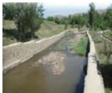
شکل ۱-۶۴- دیوار حاشیه رودخانه
