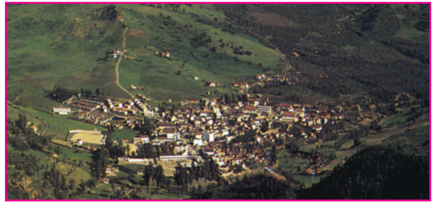
7. Fotoğraf: Toplu yerleşme örneği
