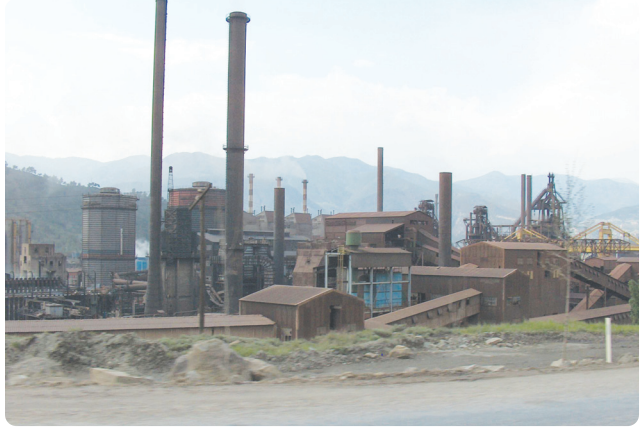
20. Fotoğraf: Ereğli’de demir-çelik fabrikası kurulmasının nedeni, yakınlarında taş kömürü çıkarılmasıdır.
