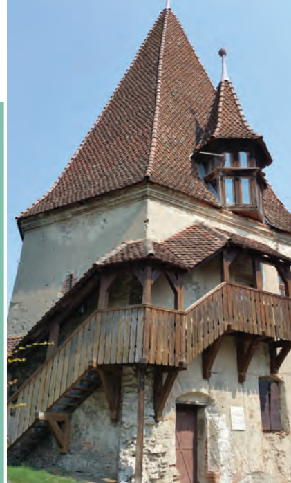
Turnul Cizmarilor - zidul de incintă al Sighișoarei
