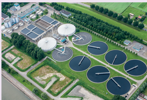
Stație de epurare a apelor uzate
