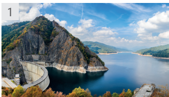
1 Barajul și lacul de acumulare de la Vidraru
