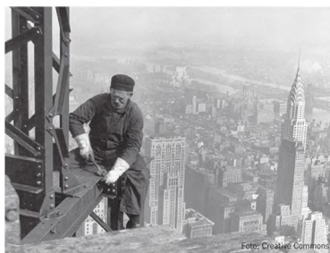
Trabajador en el Empire State Building a principios de 1930
