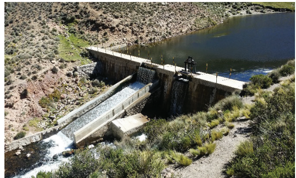
Pequeña Central Hidroeléctrica El Condor
